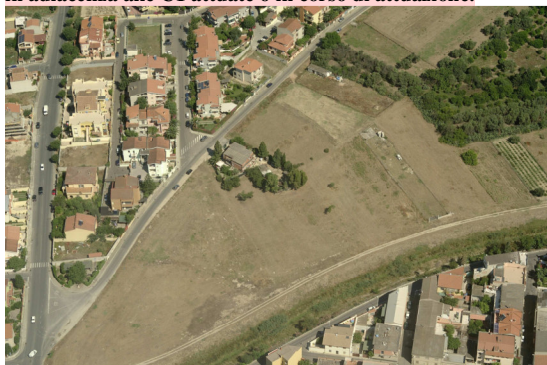
Vista obliqua dall'alto della Zona Urbanistica Omogenea C3.2, in adiacenza alle Zone B e C1 attuate.
